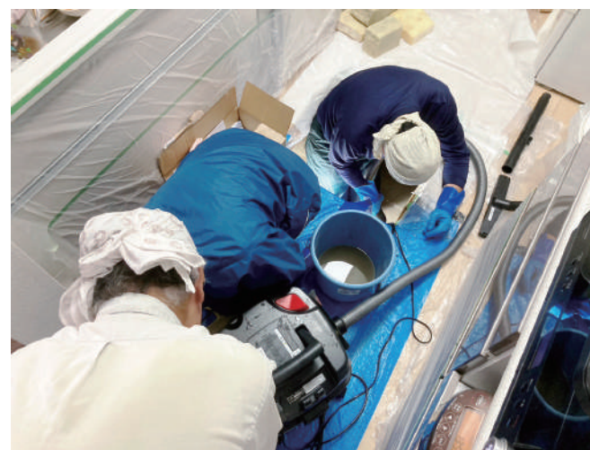
台所の床下収納からポンプで水抜き作業
