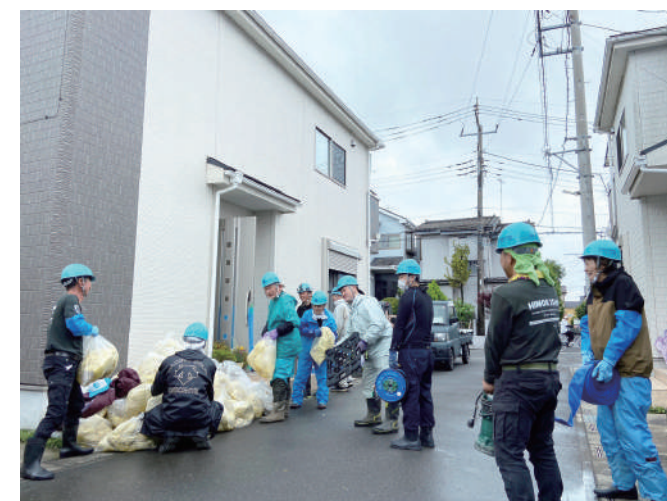
濡れた断熱材を袋詰めに
